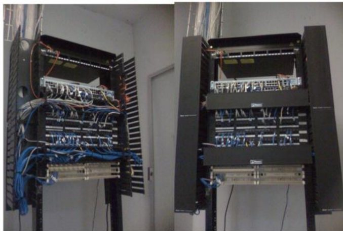
Imagen 3. Rack después de su corrección.
