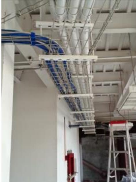
Figura 4.11 Escalerillas, cableado de Edificio
