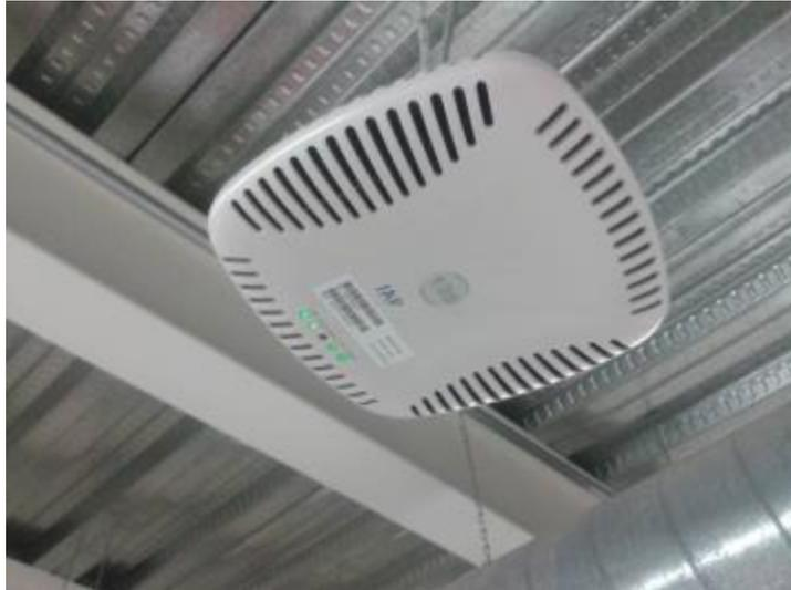
Figura 4.9 Access Point ARUBA (AP), Punto de Acceso Inalámbrico
