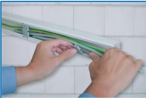
Figura 16. Cableado dentro de canaleta de pvc
