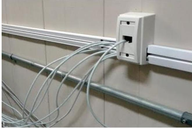
Figura 24 - Instalación de cableado con canaleta
