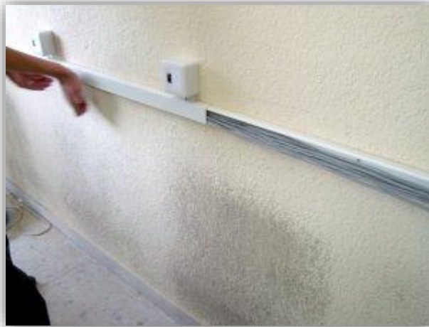
Figura 4.14 – arreglo de canaletas.
