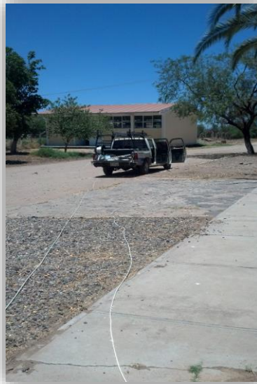
Figura 4.12 – tendido de cable en agronomía.
