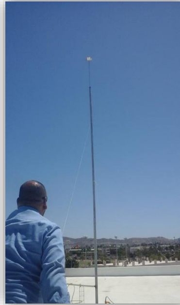
Figuras 4.10 y 4.11 – instalación de pararrayos.
