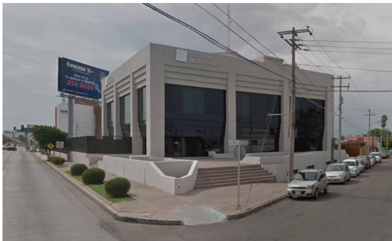
Figura 2.1 Vista del corporativo, compartiendo edificio con Seguros Monterrey.
