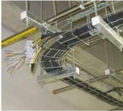
Figura 4.6 Escalerilla para cableado
