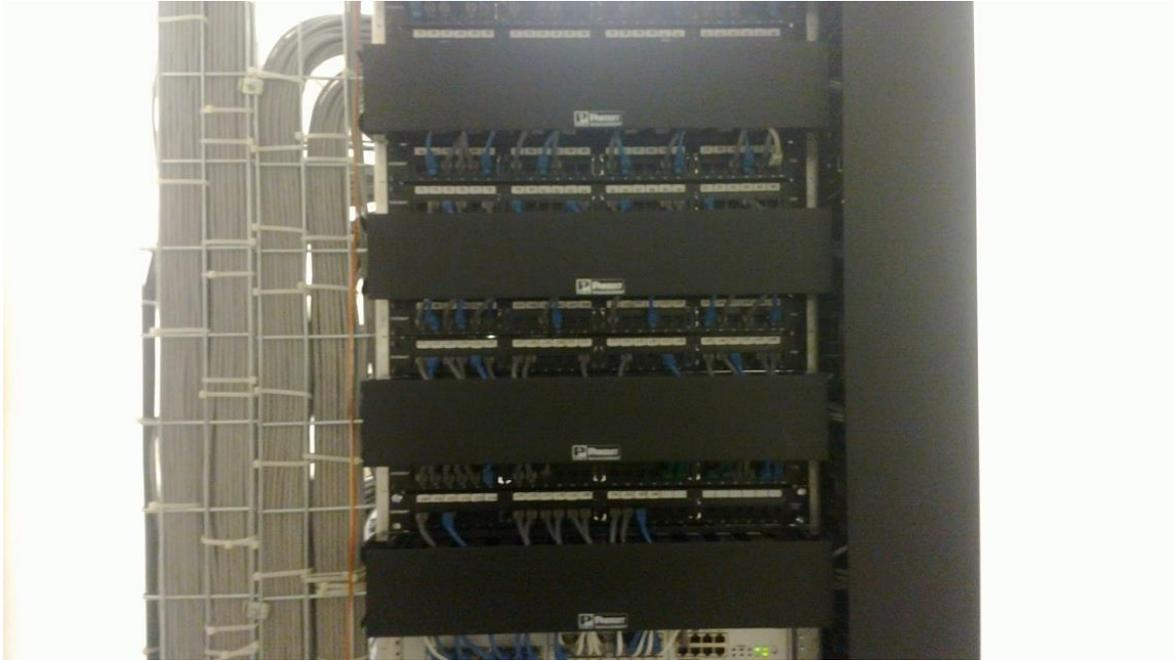
Figura 4.2 Patch panel con patch cords conectados.
