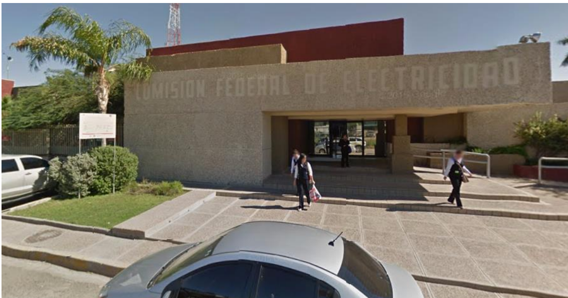
Figura 2.2 Edificio Principal, Zona de Distribución Hermosillo.
