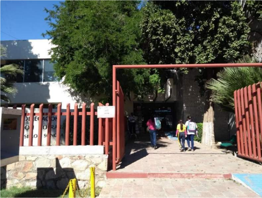
Figura 2.1 Instalaciones de la Subdelegación Hermosillo
