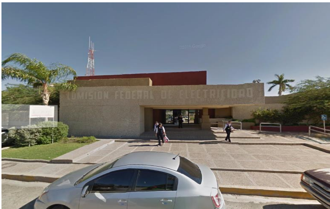
Figura 2.1 Edificio de CFE.
