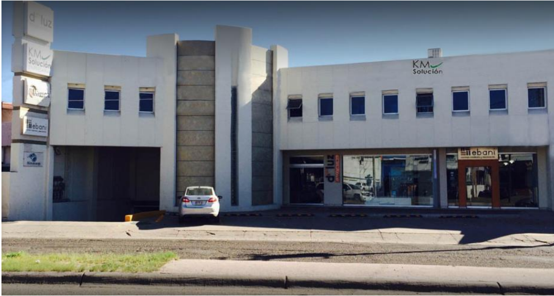
Figura 2.1 Infraestructura externa y ubicación de KM Solución
