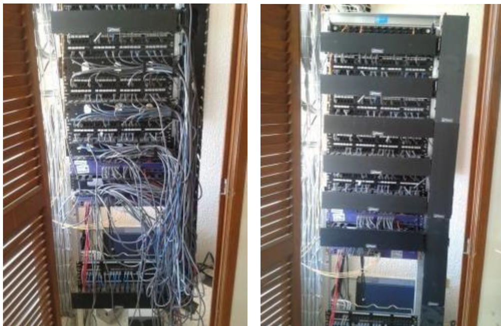
Figura 4.17 Ejemplo de mantenimiento de nodo de red
