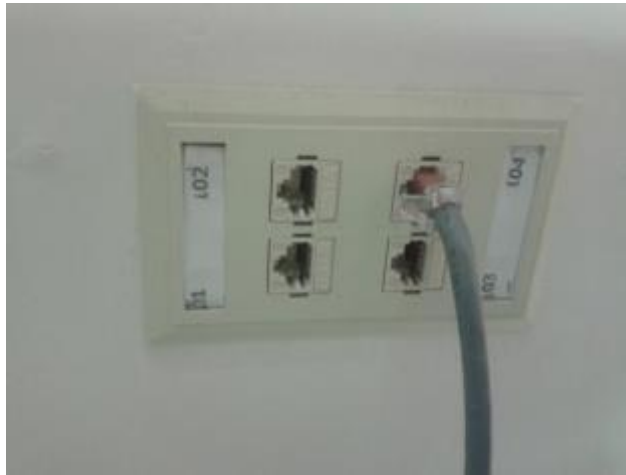
Figura 4.12 Instalación de puertos de Red, Caja de puertos
