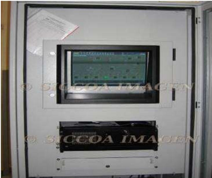
Figura 55. Ejemplo de CCL en subestación.
