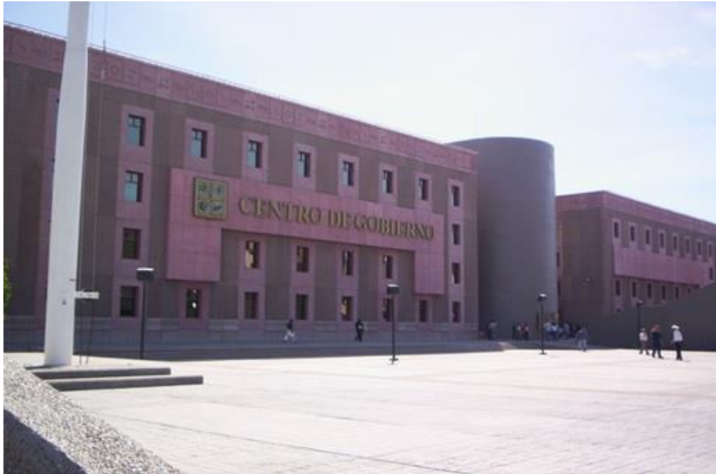
Figura 2.1 Edificio de gobierno.
