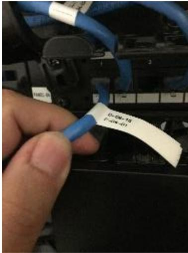
Figura 4.5 Ejemplo de etiqueta de un cable del SITE
