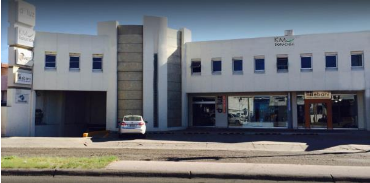
Figura 2.1. Infraestructura externa y ubicación de KM Solución.
