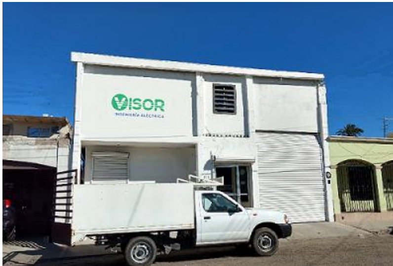
Ilustración 1 Instalaciones de Visor Electricidad.
