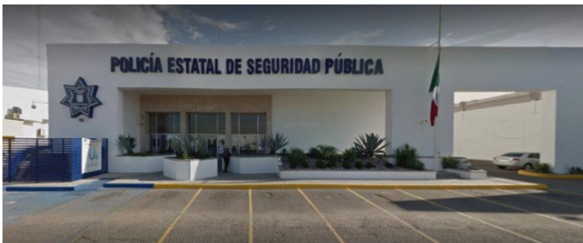
Figura 2.1 Instalaciones de la PESP
