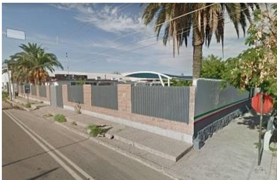
Figura 2.1. Instalaciones del Servicio Geológico Mexicano
