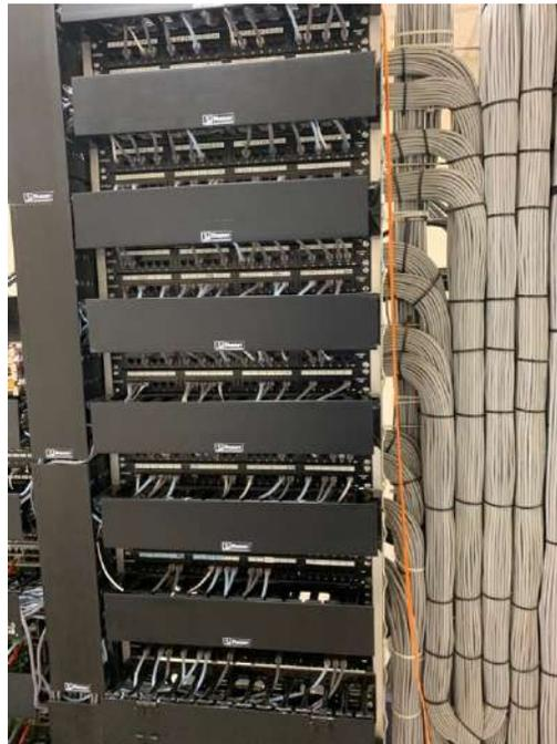
Figura 5.7 – Ejemplo de Cableado Estructurado
