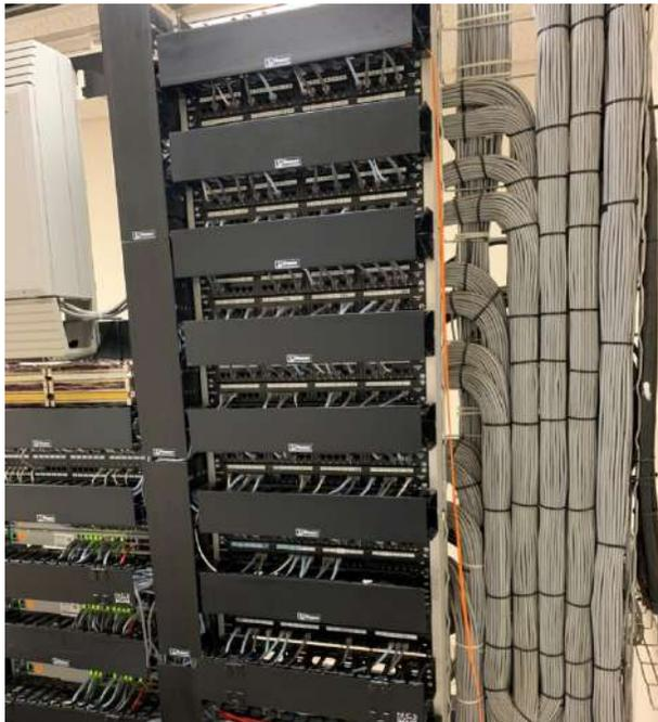
*Figura 5.13 – Vista de un Patch Panel*
