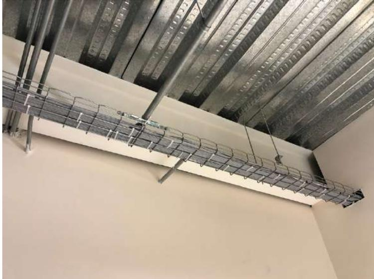
Figura 5.14– Canal para Cables de Red
